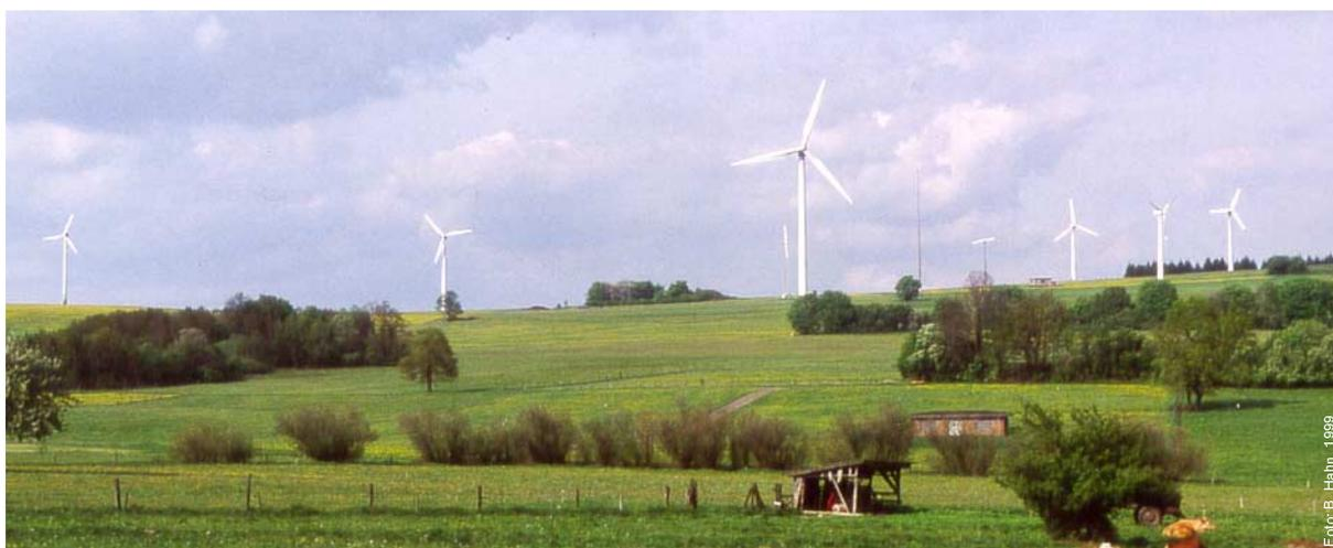
**Abb. 9: Windkraftanlagen in Hartmannshain(von links): Enercon 17, AN Bonus 150, Testfeld-Anlage Aeroman, Tacke TW 1.5, HSW 30, HSW 250 T, Tacke TW 250, HSW 250, zwischen TW 1.5 und HSW 30: 50 m-Windmessmast**
