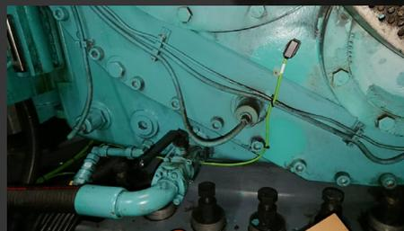
GE 1,5-MW-Getriebe mit ecoCMS-Beschleunigungsmessern nachgerüstet
